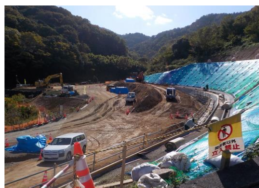
※下流側砂防堰堤の管理用道路工事
