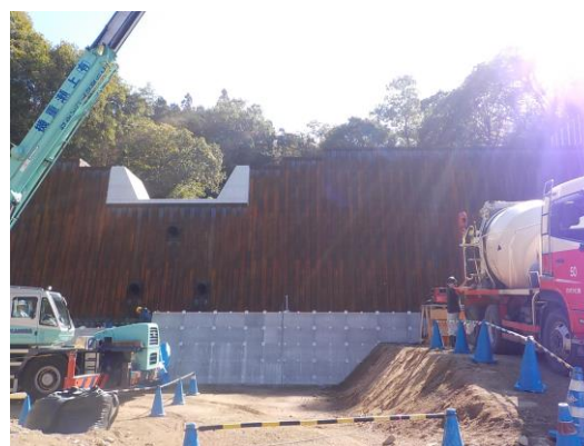
亀石川(亀石山：広島県施工)
