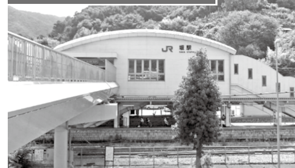
写真③ 令和4年9月 [北口から撮影]
