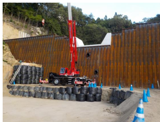
亀石川(亀石山：広島県施工)
