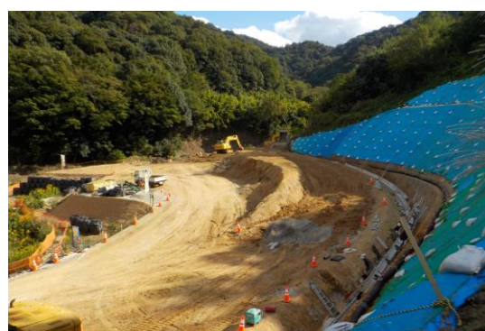
※下流側砂防堰堤の管理用道路工事
