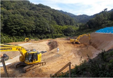
※下流側砂防堰堤の管理用道路工事
