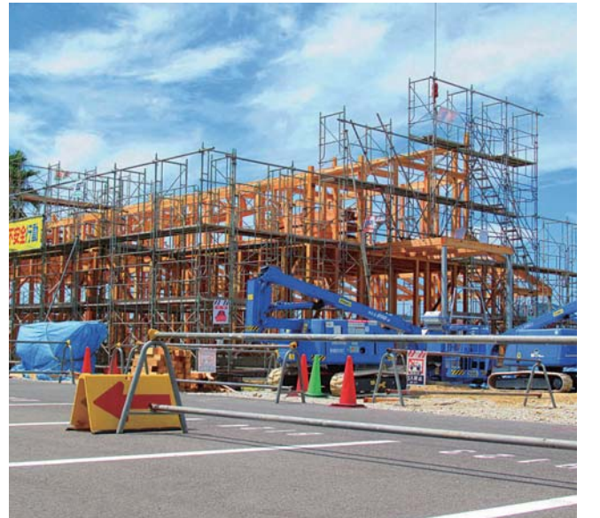
ベイサイドビーチ坂で建設が進む飲食棟
