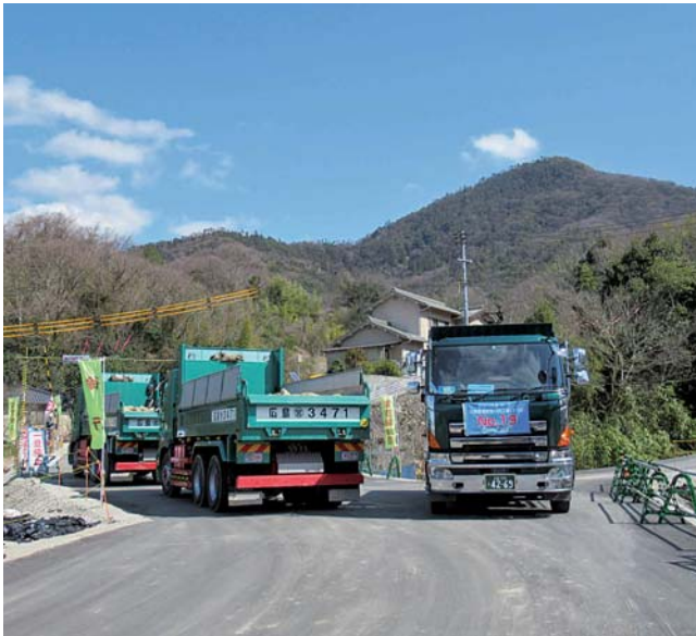
砂防ダム工事用道路を町道に
