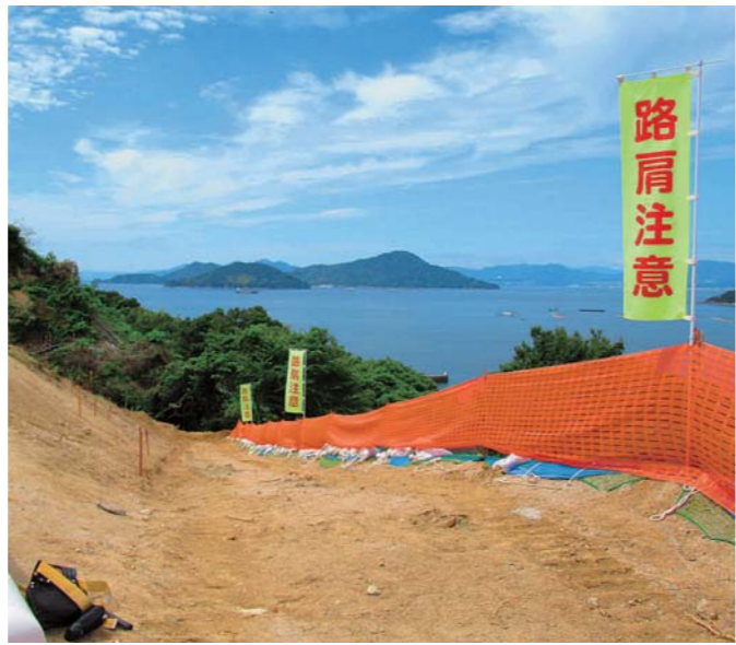
町道植田水尻側道線の工事はじまる
