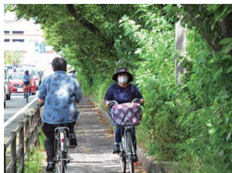
枝が茂って危険な歩道
