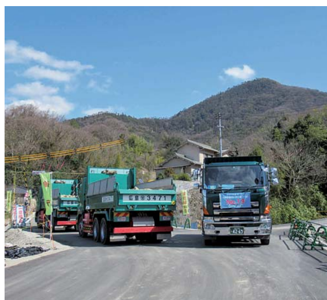
砂防ダム工事用道路を町道に
