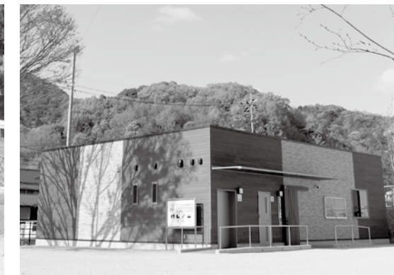
▲坂町災害伝承ホールの整備
