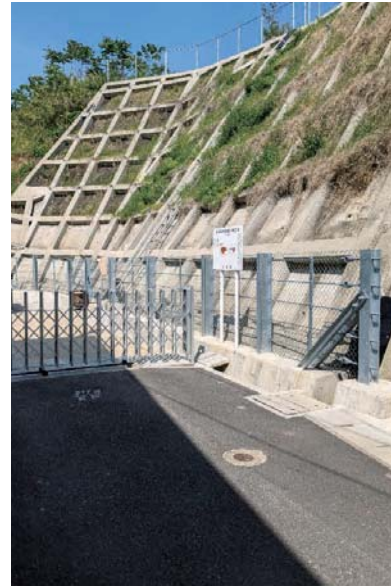
工事が完了した急傾斜地
