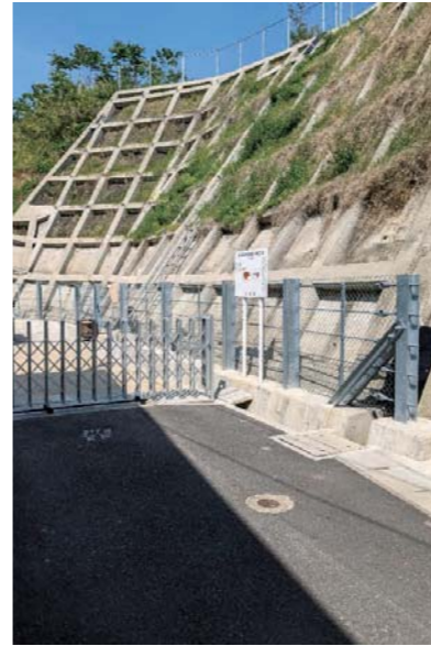
工事が完了した急傾斜地
