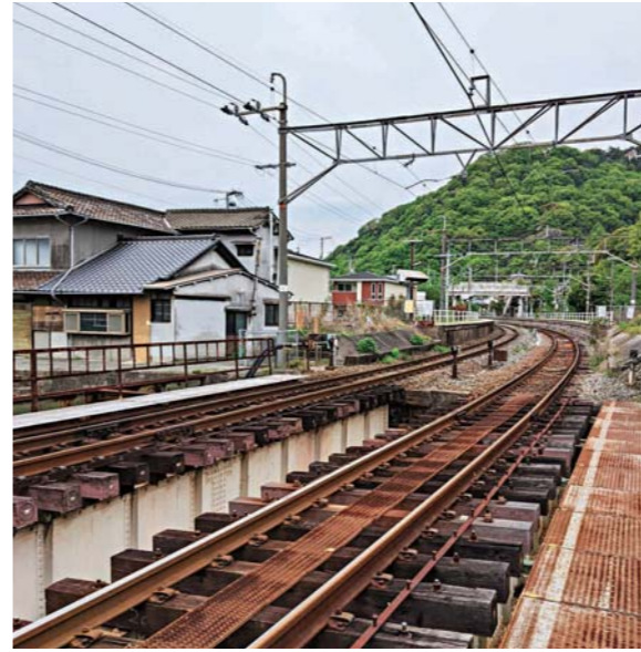
JR小室浦駅南口改札口新設を望む
