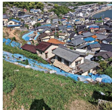
工事が待たれる急傾斜地
