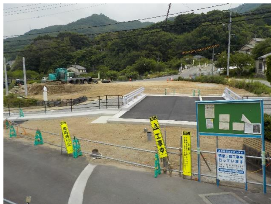
総頭川1号線（寺参橋）
