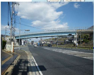
植田橋 L=54.0m (鋼橋) 1996 年架設
