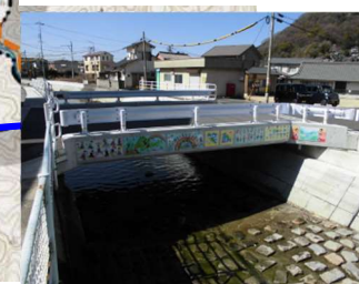
天地橋 L=9.8m (PC 橋) 2021 年架設 (架替)
