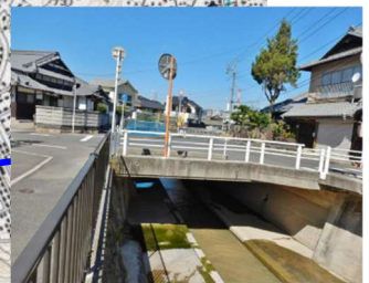
森浜橋 L=8.7m (RC 橋) 1961 年架設
