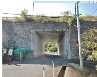
植田 BOX L=6.9m (BOX) 1996 年架設
