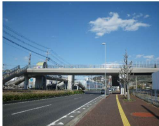
自由通路 L=115.0m (鋼橋) 2000 年架設
