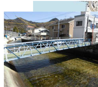
藤向橋 L=14.7m (鋼橋) 1965 年架設
