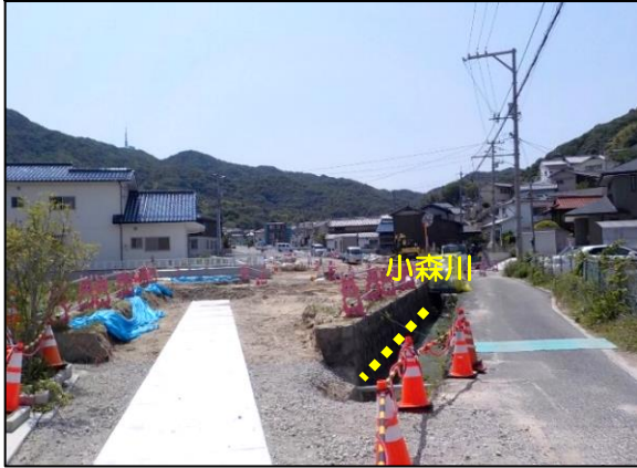
ボックスカルバート設置
