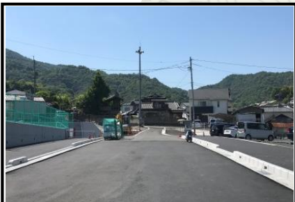
【2 工区】 荒神橋付近から、上条地区の向 田橋付近まで、測量結果を踏まえ 昨年度、調査・設計を行いました。
