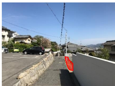
(西側2号線拡幅工事)
