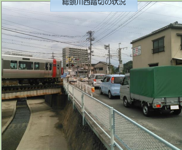
総頭川西踏切の状況
