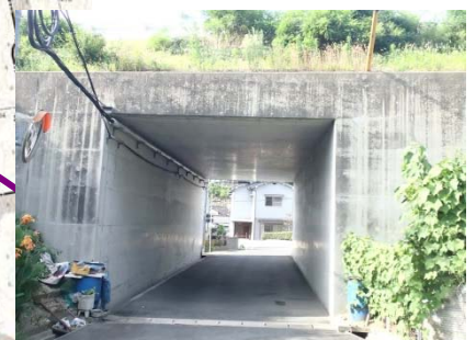
植田ボックス L=6.9m(BOX) 1996年架設
