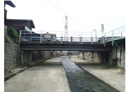
恵美須橋 L=12.3m(RC橋) 1960年架設
