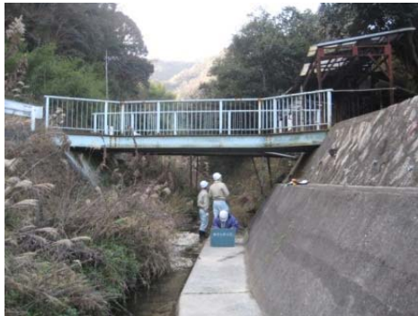
橋梁点検（上部工）
