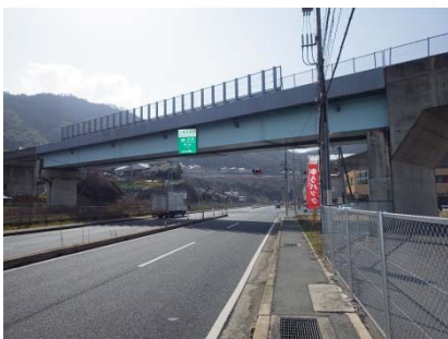
植田橋 L=54.0m(鋼橋) 1996年架設
