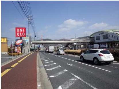
自由通路 L=115.0m(鋼橋) 2000年架設
