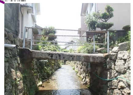
酒屋橋 L=3.3m(石橋) 1960年架設
