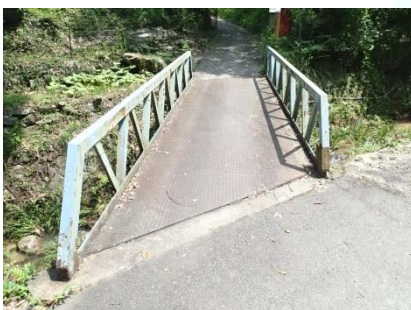
水尻橋 L=6.3m(鋼橋) 1974年架設
