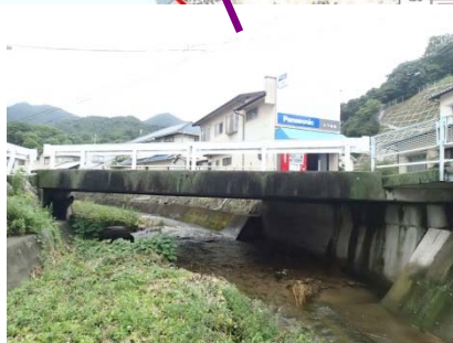
二本橋 L=13.5m(PC橋) 1967年架設
