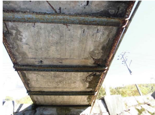
横桁の腐食
