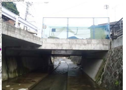
森浜橋 L=8.7m(RC橋) 1961年架設
