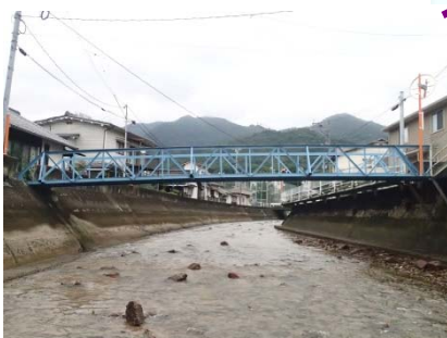
藤向橋 L=14.7m(鋼橋) 1965年架設
