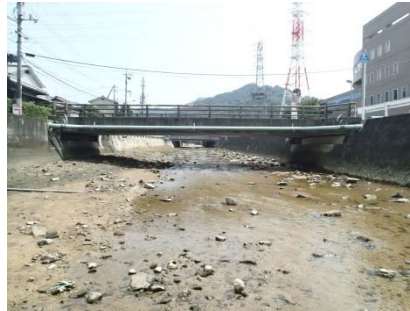
下総頭橋 L=19.7m(PC橋) 1990年架設
