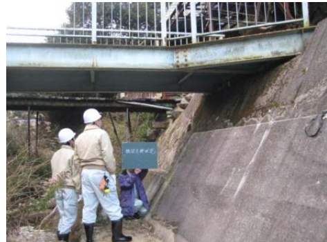
橋梁点検（下部工）
