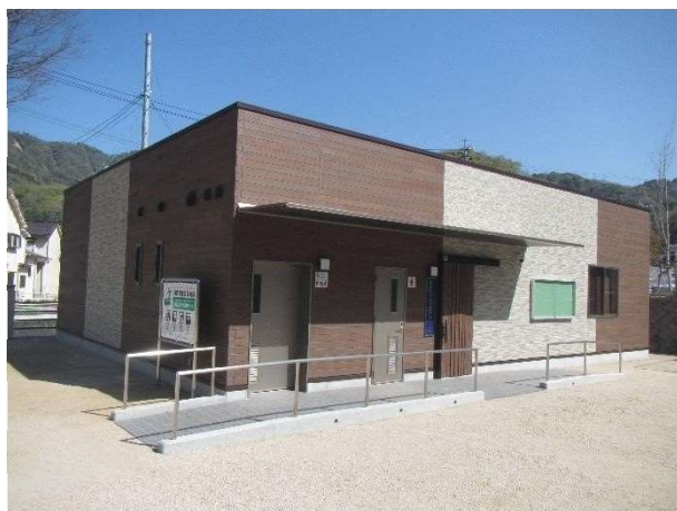
坂町災害伝承ホールの整備
