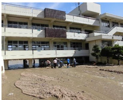
駐車場とピロティ付近
