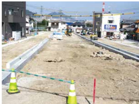
完成間近の県道
