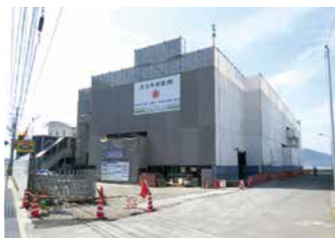
工事中の小規模特別養護老人ホーム
