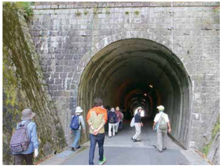
上條トンネルの補修
