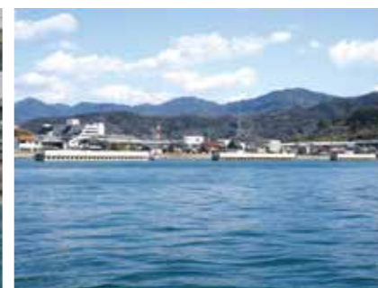
残り1基の離岸堤
