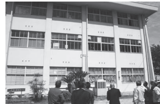
学校耐震化工事の現地調査を行う委員会
